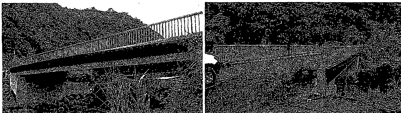
Pont routier permettant le désenclavement du secteur Pirae
