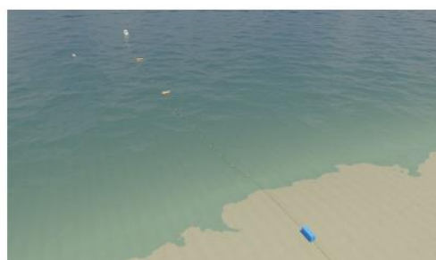
Câble maintenu par des flotteurs et déroulé par les navires.
